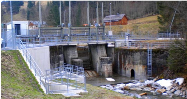
Abb. 1: Wehranlage Kraftwerk Braz - Fischwanderhilfe links
